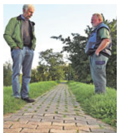
Die Ausschussmitglieder Udo Giese und Rolf Lühders (links) begutachten den Deichweg. Foto Tiemann
